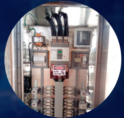
Suministro e instalación de filtro de rechazo automatico de capacitores para implementación de corrección de factor de potencia en agropalm ingredients api coatzacoalcos AGOSTO DEL 2022
